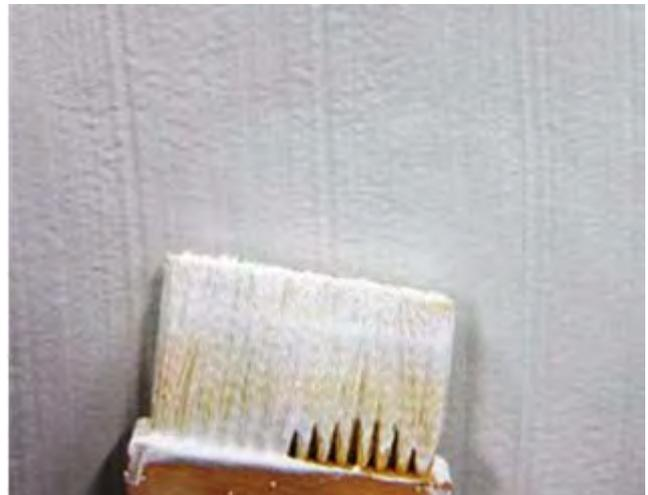
**(c) Aplicación:** MasterSeal 6100 FX puede ser aplicado mediante cepillo, a llana o proyectado. Aunque la aplicación con rodillo no es recomendable.
